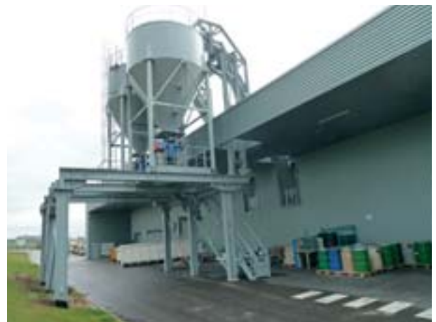
6. À l'arrière du bâtiment, les différents gisements à retirer. Les métaux sont dans les bennes. Et en haut, les deux cônes stockent les poudres de verre : l'un destiné aux tubes Marvell Glass et l'autre au flaconnage ou à la laine de verre.
